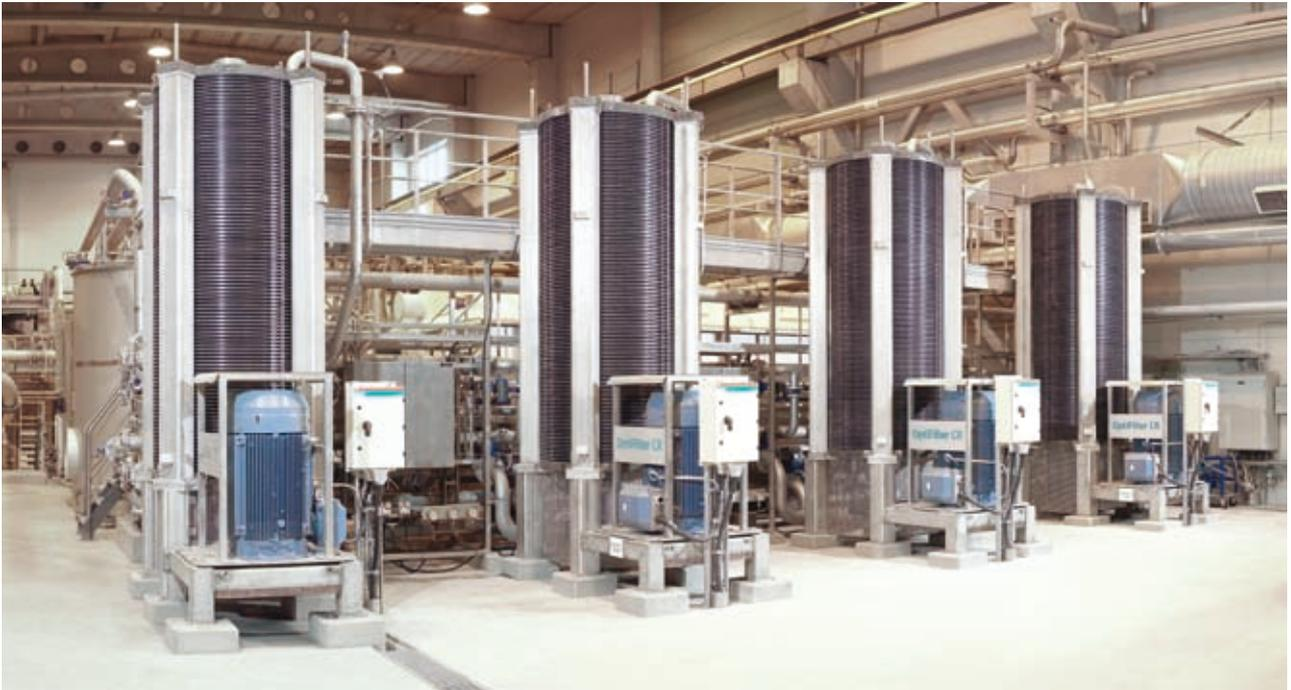
图4 安装于Propapier纸厂2<sup>#</sup>纸机的OptiCycle W 超滤系统
