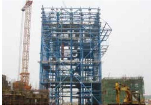
2003年12月17日，正在安装建设中的金海浆纸碱回收锅炉。该环保设备可完全回收利用制浆黑液，借由燃烧黑液所产生的热量将水转换成蒸汽发电，供给全厂所需的大部分电力及热源，使得在确保环境不被破坏的同时，纸浆的制造成本也得以大幅降低
